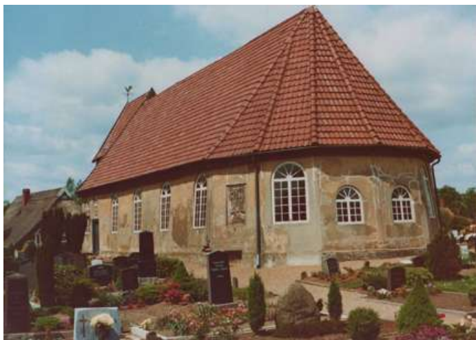
Die Bardenflether St. Anna Kirche vor der Renovierung 1980
